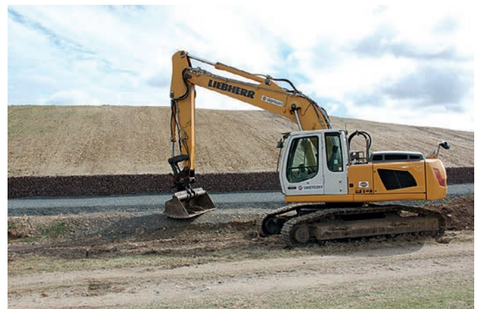
Arbeiten am Randgraben Deponie Cunnersdorf (Fotos: ZAOE)
