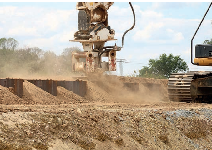
Spundwandarbeiten Abschnitt 5, Deich Brottewitz, 2019
