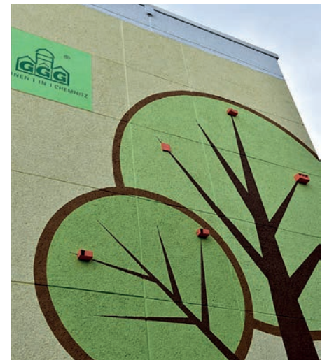
Abb. 3: Hier hat eine Chemnitzer Wohnungsgenossenschaft Nistkästen geschickt in eine farblich gestaltete Fassade integriert.
