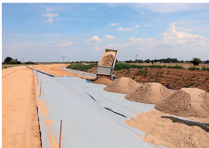
Deichaufbau Neudeich Abschnitt 6, August 2019
