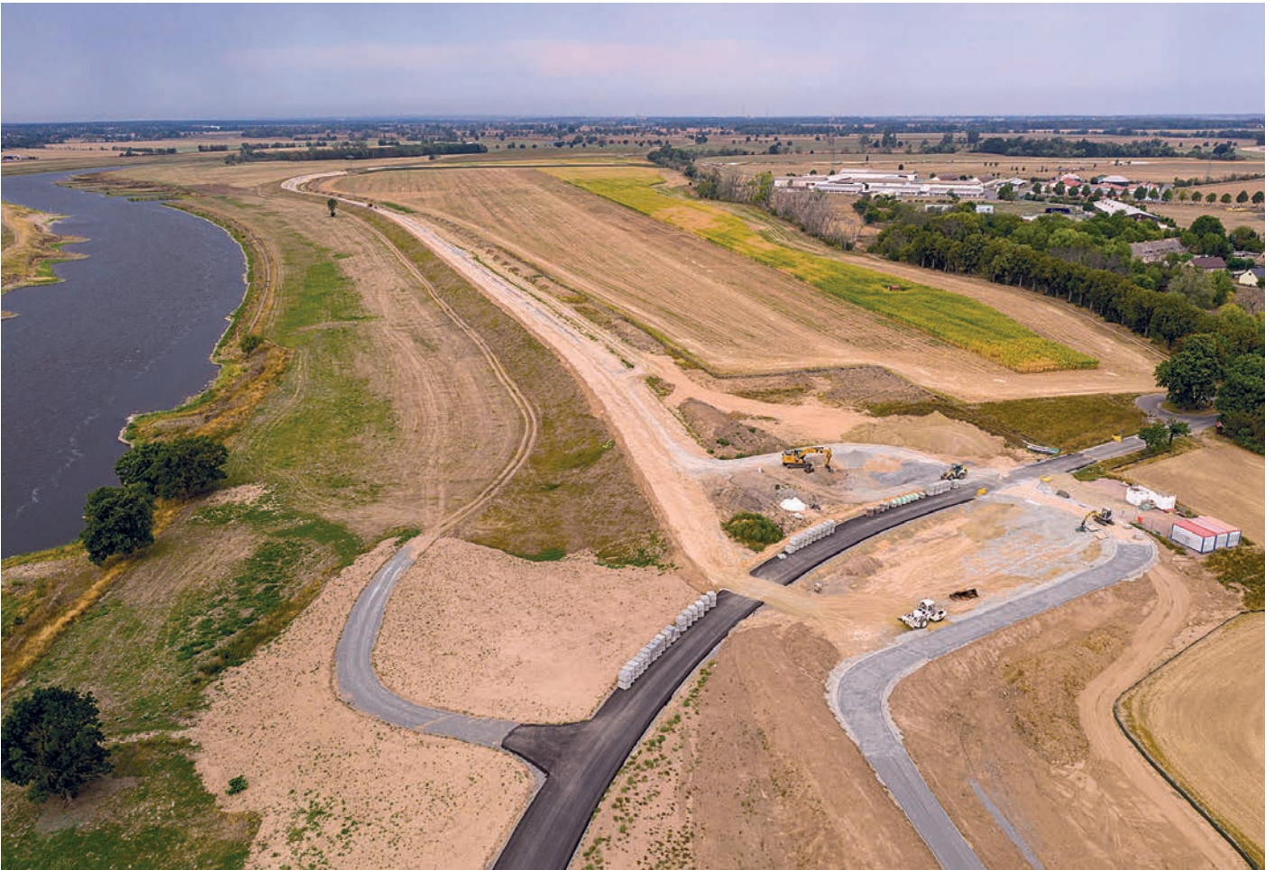
Instandsetzung Abschnitt 5, September 2019
