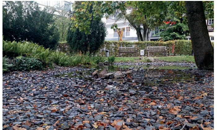
Die Entwässerung auf der Fläche auf dem Gelände des St. Elisabeth Krankenhaus in Leipzig fügt sich in die Gestaltung der Freiflächen als Gestaltungselement ein (Foto: StadtLand GmbH, 2020)
