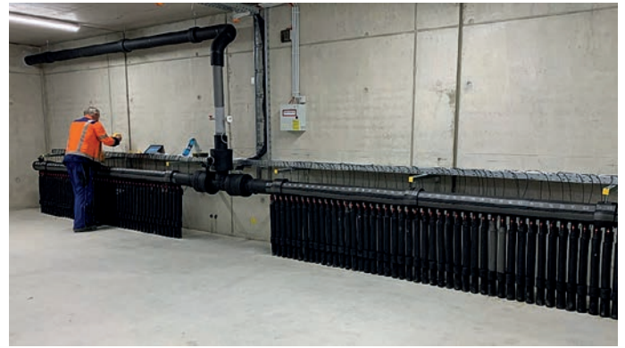
Gebäudedurchführung nach dem Betonieren der Bodenplatte mit montierter Vorlauf-Verteilereinheit (Foto: BAUER Resources GmbH)
