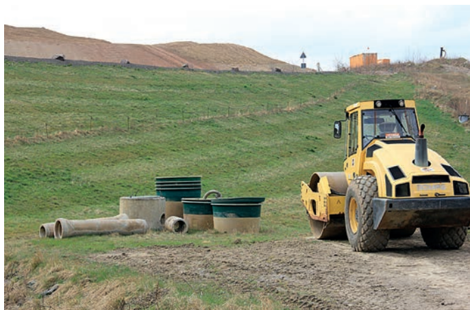
Ausgebaute Gasbrunnen und Gasrohre auf der Deponie Cunnersdorf
