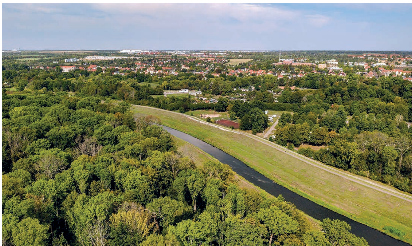
Beim Bau der Neuen Luppe in den 1930er-Jahren zum Hochwasserschutz wurden zahlreiche Nebenarme der Weißen Elster und der Luppe unterbrochen. So wurde die Wasserzufuhr des Auwaldes weitgehend gekappt. (Foto: André Künzelmann / UFZ)
