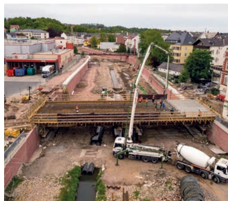
Betongang neue Brücke (Foto: LTV)
