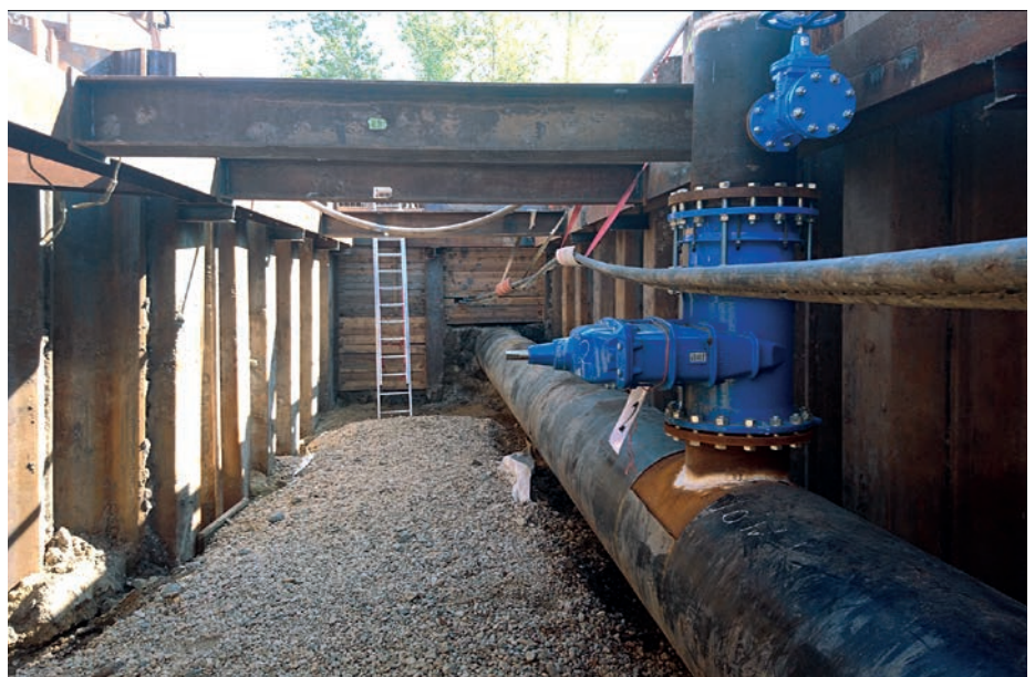
Baugrube zur Einbindung mit Bypassleitung DN 600
