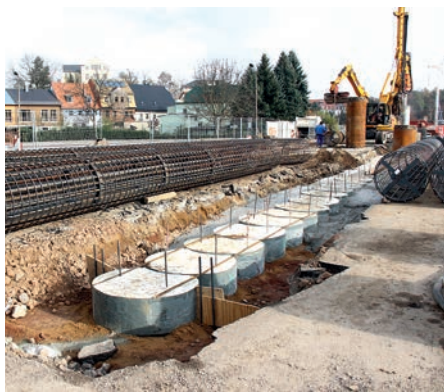
Flutmulde – Bewehrung für Bohrpfähle (Foto: LTV)
