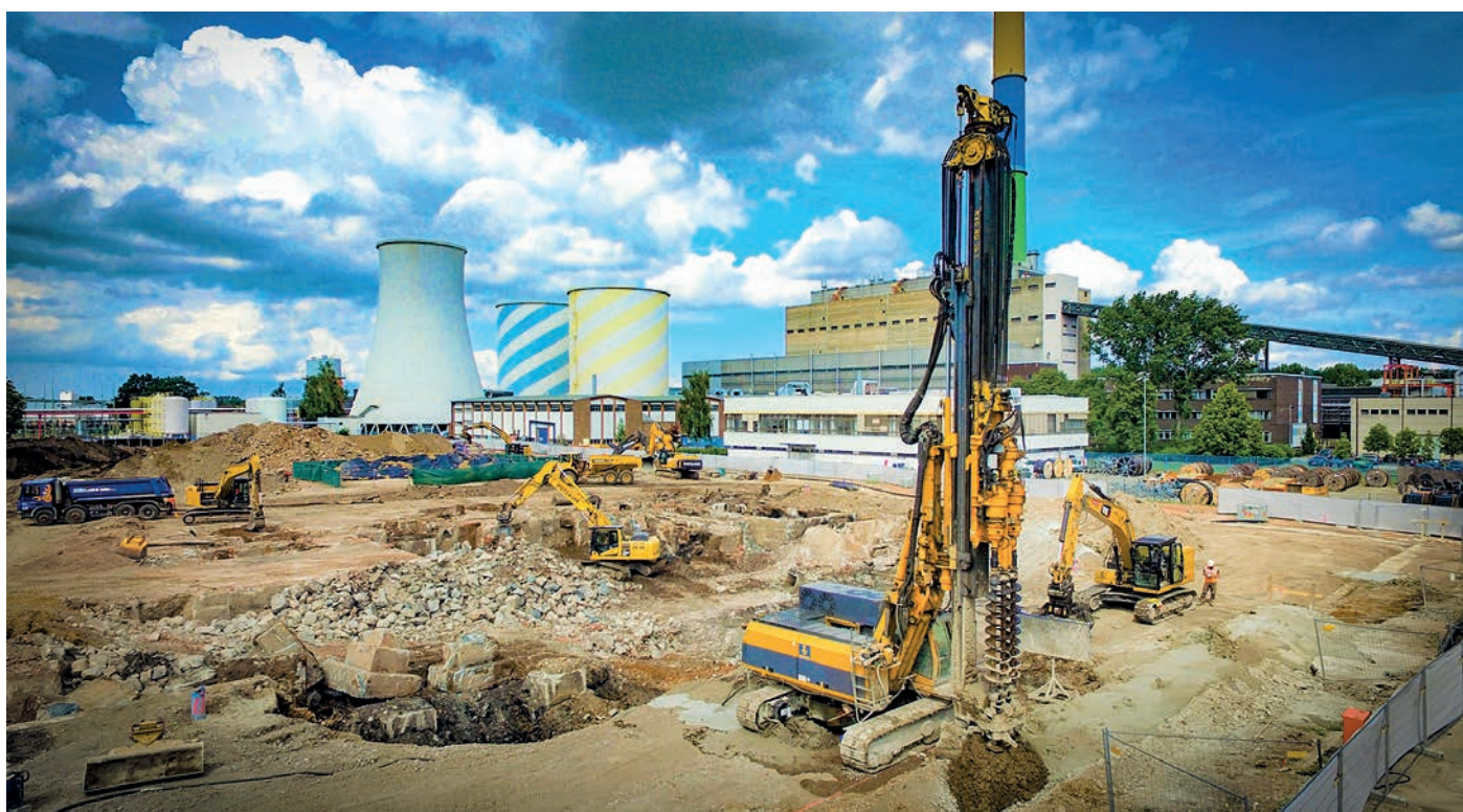
Abbildung 2: Herstellung MIP-Wand (Foto: BAUER Spezialtiefbau GmbH)
