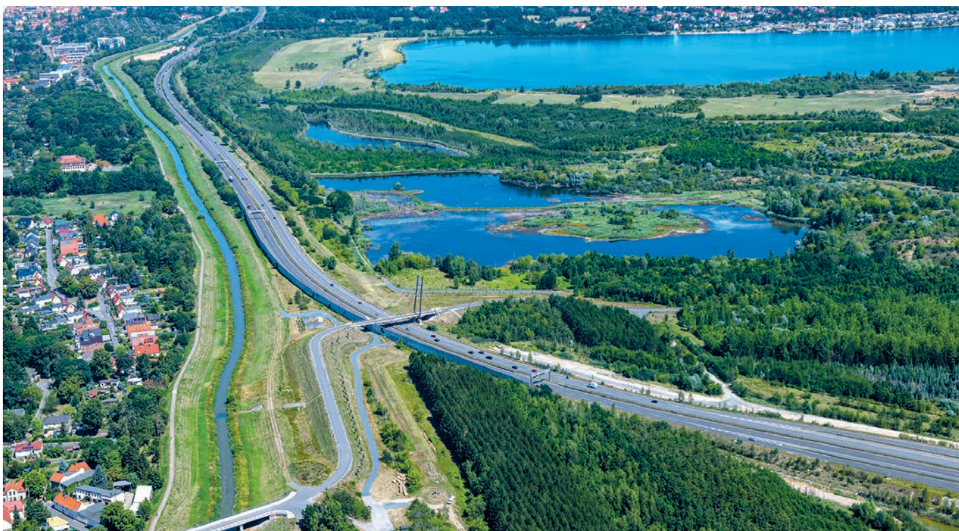
Bild 2: Die Neuseenbrücke im Bereich Markkleeberg-Gaschwitz föhrt über die B 2 und stellt eine direkte Verbindung zwischen den Seenpaaren Cospuden/Zwenkau und Markkleeberg/Störmthal her. (Foto: LMBV, Peter Radke)
