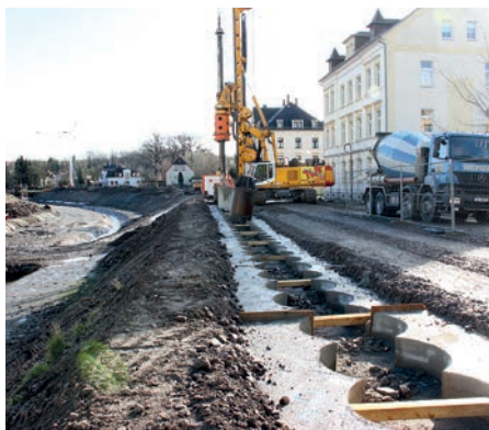
Bohrpfahlarbeiten Flutmulde (Foto: LTV)
