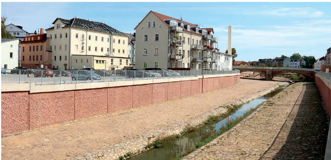
Flutmulde – fertiger Bauabschnitt (Foto: LTV)
