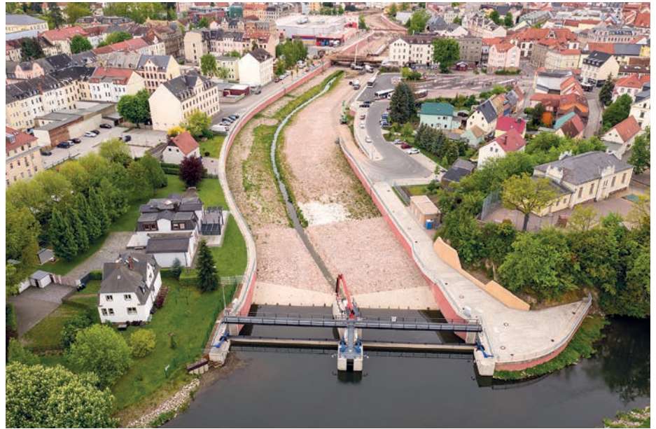
Neues Verteilerwehr und verbreiterte Flutmulde (Foto: LTV)
