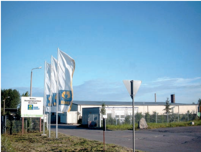
Einfahrt ins BRZ Hirschfeld (Foto: U.Schlenker/BRE)
