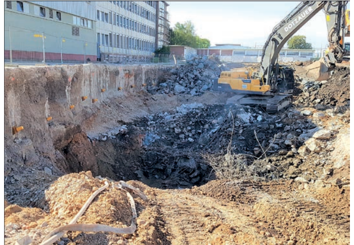
Abbildung 4: Verankerte MIP-Wand und Fundamentabbruch (Foto: BAUER Spezialtiefbau GmbH)
