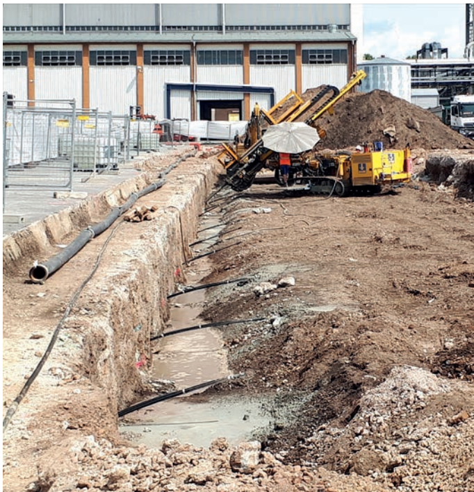
Abbildung 3: Herstellung Verankerung (Foto: BAUER Spezialtiefbau GmbH)
