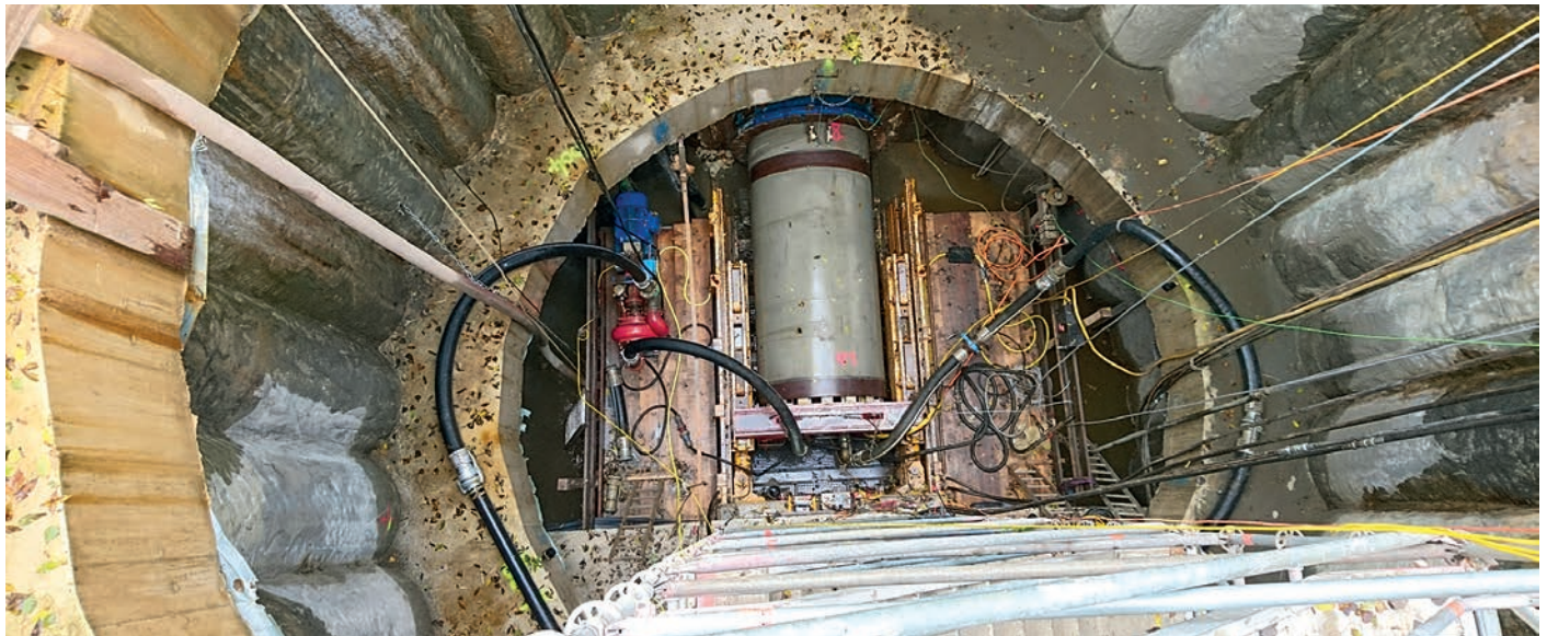
Startgrube für Microtunneling
