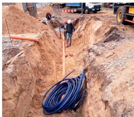
links: Rückbau befestigter Flächen von Beton und Asphalt / rechts: Rohrleitungsgraben für Schmutzwasser, Regenwasser und Bauwasser verlegt (Fotos: UTS GmbH Ueckermünde)
