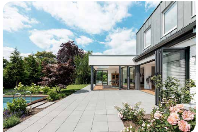
Die Neugestaltung mit der Glas-Faltwand schafft einen fließenden Übergang in den Garten. (Fotos: djd/www.solarlux.com/Bettina Meckel)
