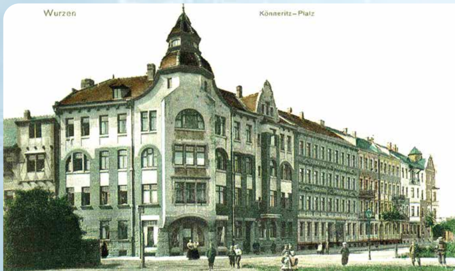
Imposante Bebauung entlang des ehemaligen Könnerritzplatzes, heute Bürgermeister-Schmidt Platz
