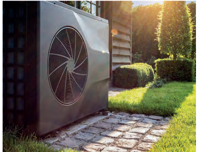
Moderne Luft-Wasser-Wärmepumpen nutzen die Wärmequelle Luft so effizient, dass sie auch in älteren Wohnhäusern eingesetzt werden können. (Foto: djd/SHK/Nancy Pauwels/Shutterstock)
