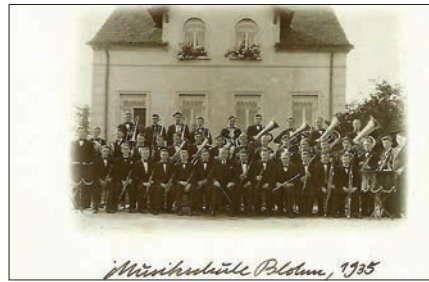
Kapelle vor Wohnhaus Weststr. 8 (1935)
