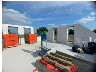
Bauvorhaben „An den Streuobstwiesen“
