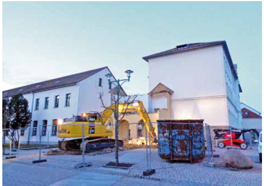
Abbruch des Übergangs vom alten Schulgebäude zum Hauptgebäude
