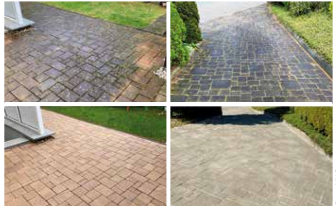
Zwei Steinflächen jeweils vor (oben) und nach der Sanierung (unten).
