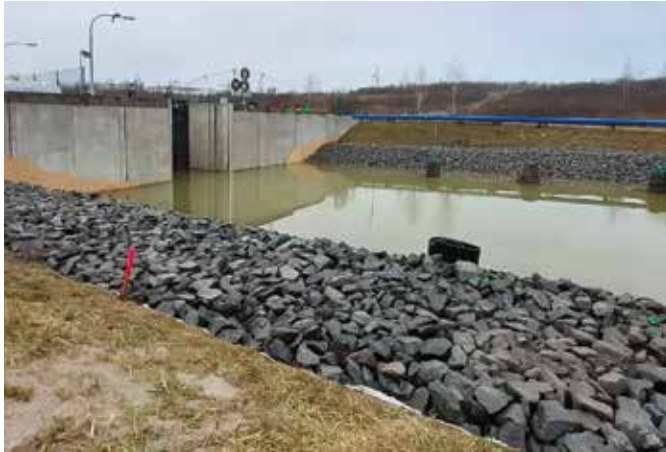
Befestigung der Böschung unterhalb der Kanuparkschleuse mit Wasserbausteinen, im Hintergrund die blaue Heberleitung, Januar 2022. (Foto: LMBV)
