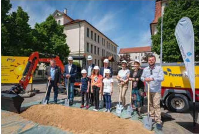
Erster Spatenstich für das Glasfasernetz auf dem Lindenplatz. (Foto: Christian Kortüm / envia TEL)
