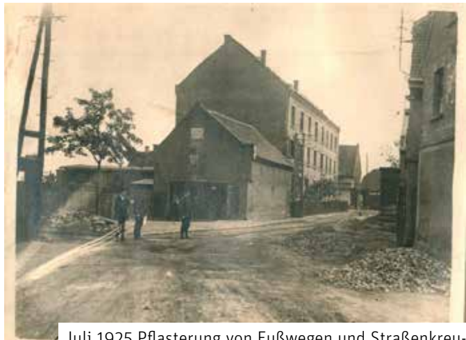
Juli 1925 Pflasterung von Fußwegen und Straßenkreuzung sowie Schotterung der Dorfstraße in Kulkwitz
