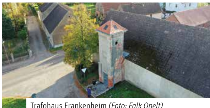
Trafohaus Frankenheim (Foto: Falk Opelt)
