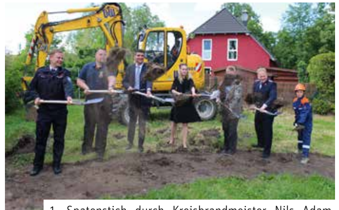
1. Spatenstich durch Kreisbrandmeister Nils Adam, Stadtwehrleiter Sven Haetscher, Landrat Henry Graichen, Bürgermeisterin Nadine Stitterich, Planer Dennis Kraft, Ortswehrleiter Michael Bloyl und Jugendwehr (v.l.)
