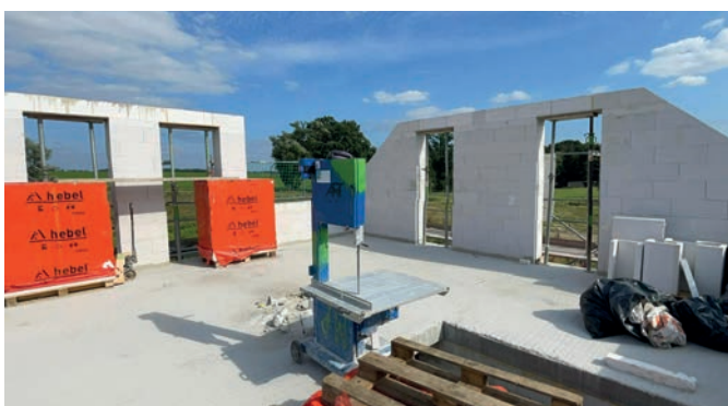
Bauvorhaben „An den Streuobstwiesen“
