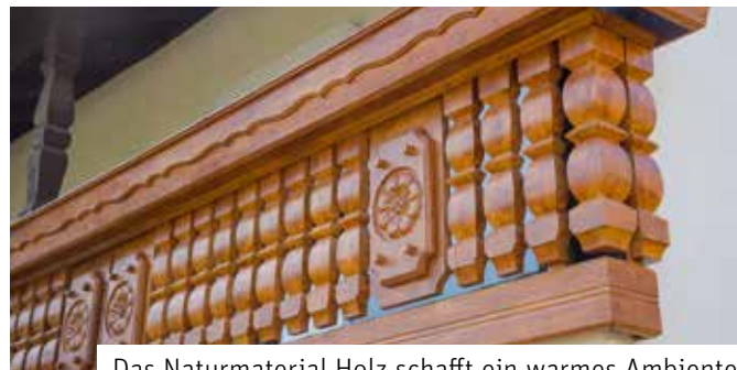
Das Naturmaterial Holz schafft ein warmes Ambiente, muss aber auch regelmäßig mit einem schützenden Anstrich gepflegt werden. (Foto: djd/www.adler-farbenmeister.com )
