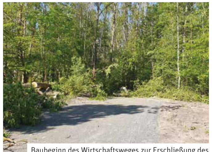
Baubeginn des Wirtschaftsweges zur Erschließung des Pappelwaldes
