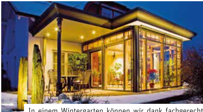
In einem Wintergarten können wir dank fachgerecht verbauter Wärmedämmung und 3-fach Isolierverglasung auch an frostigen Tagen viele schöne Stunden verbringen. (Foto: epr/Wintergarten Fachverband e.V.)
