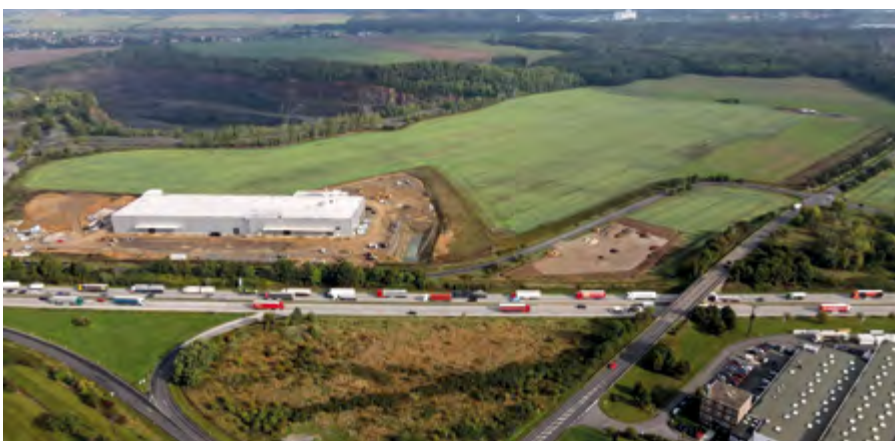
Dritter Bauabschnitt Gewerbegebiet Grimma (Foto: fsw-foto)
