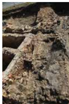
Abb. 2: das Fundament der Stadtmauer (Blickrichtung Meißner Straße), teilweise überlagert mit jüngeren Fundamenten des Hotel de Saxe; links sind zwei Kellerräume des Hotels zu sehen.
