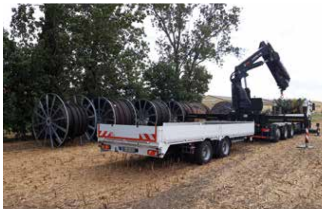
Anlieferung HDPE-Rohr für Außerortsverbindung Skäßchen-Skaup Foto: ENSO NETZ/Grell.
