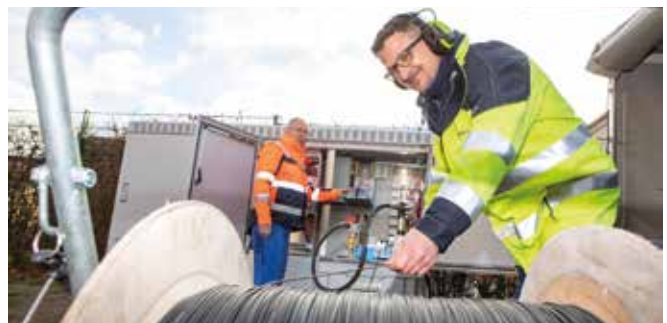
Die ENSO NETZ-Mitarbeiter Steffen Forker und Michael Kaiser beim sogenannten „Einjetten“ der Glasfaserkabel vor einem der neuen Verteilerschränke. Von hier aus führen später die Glasfaserkabel in die Häuser. Foto: ENSO NETZ, Weidler
