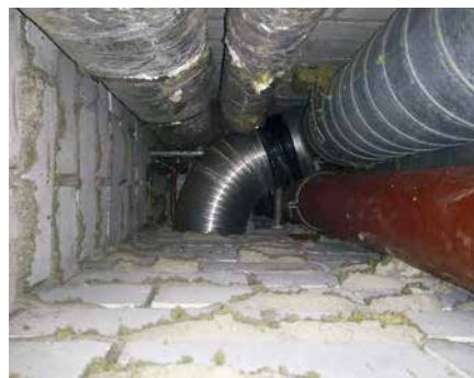
Das Material wird eingeblasen, ummantelt dabei sämtliche Rohre, die durch die Schächte verlaufen, und dichtet die Hohlräume vollständig ab. (Foto: epr/Ecofibre.de)
