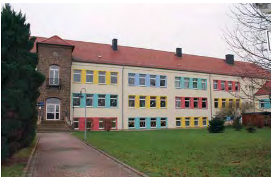
Mit LEADER-Mitteln wurde u.a. die Grundschule in Beucha modernisiert.
