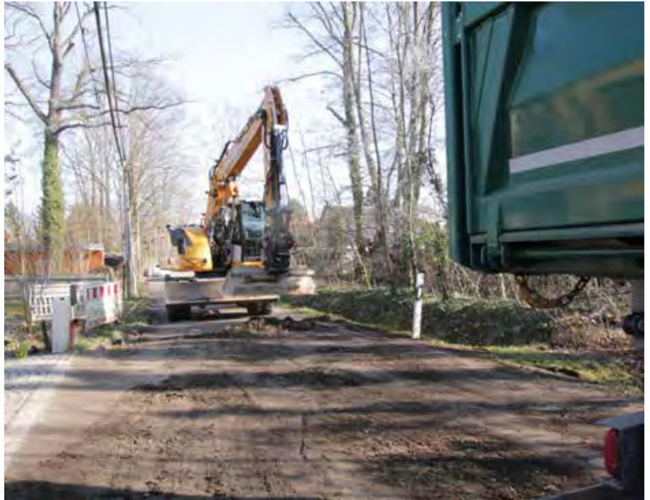
Nachdem die vorbereitenden Arbeiten liefen, wird der Lönsweg instandgesetzt.
