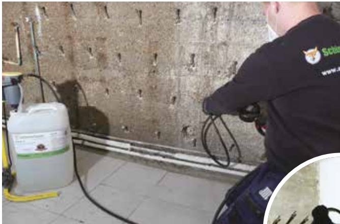
Dank des innovativen und bewährten Produktes ist – selbst bei starker Durchfeuchtung – keine Ausschachtung notwendig. (Fotos: Schimmelfuchs Abdichtungstechnik GmbH)
