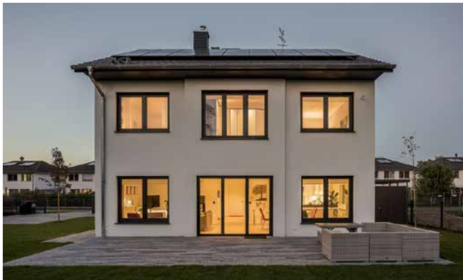
Die Stadtvilla in Birkenwerder bei Berlin verfügt über Beleuchtungssteuerung im ganzen Haus, Rollladensteuerung, Fensterüberwachung, Alarmanlage, Bewegungsmelder und vieles mehr.
